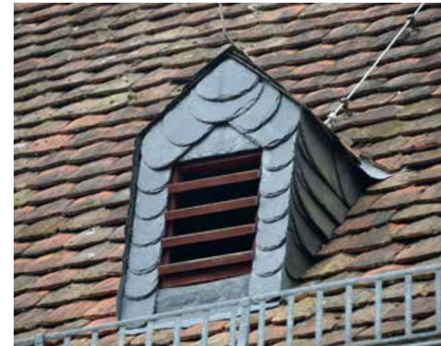
Einflugöffnung für Fledermäuse im Kirchturm Nieder-Wiesen
