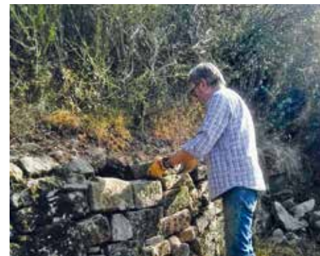
Die Mauer wird repariert
